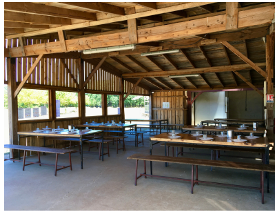
Une cloison sous le préau remplace les bâches.
